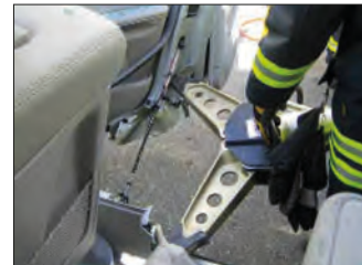
Imagen 216. Maniobra de separación
