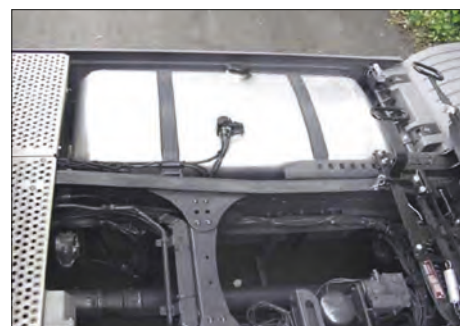
Imagen 115. Posible punto de corte de tubería de combustible
