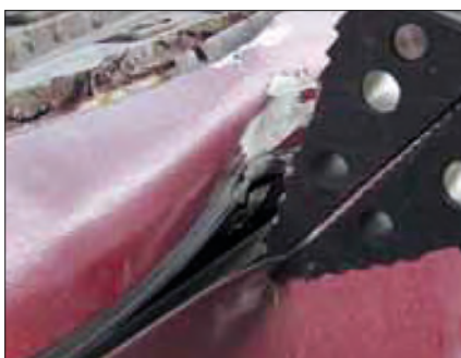
Imagen 228. Ensamblamiento de la apertura
