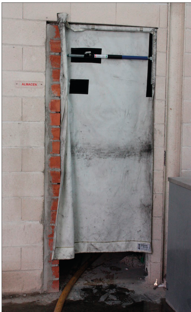
Imagen 154. Paso de manguera por debajo de cortina de bloqueo de humo
