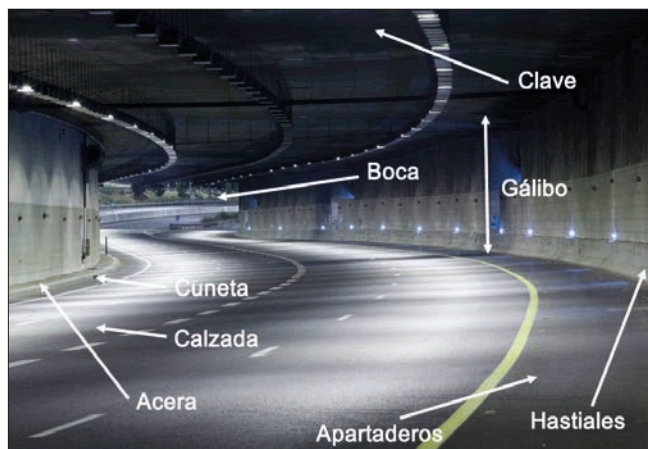
Imagen 1. Partes de un túnel
