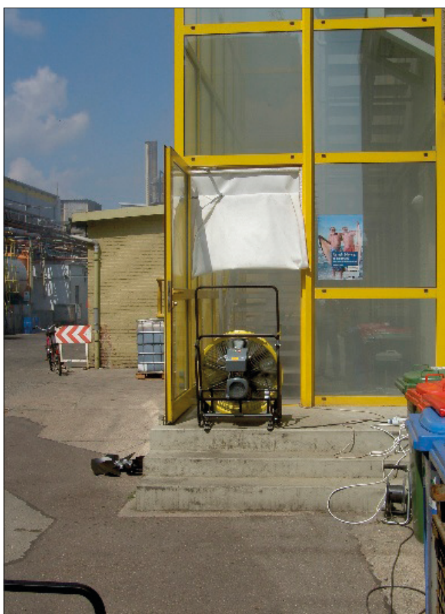
Imagen 139. Cortina de bloqueo de humo recogida hasta media altura para reducir el tamaño de la apertura de entrada y conseguir una mayor presurización. En este test se consiguió aumentar la presión desde los 30Pa de media con la apertura completa a 60Pa con la apertura al 50%
