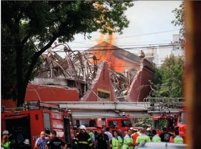
Imagen 164: El colapso de una estructura durante las tareas de extinción de una nave industrial en Barracas (Buenos Aires, Argentina) se llevó la vida de 10 bomberos
