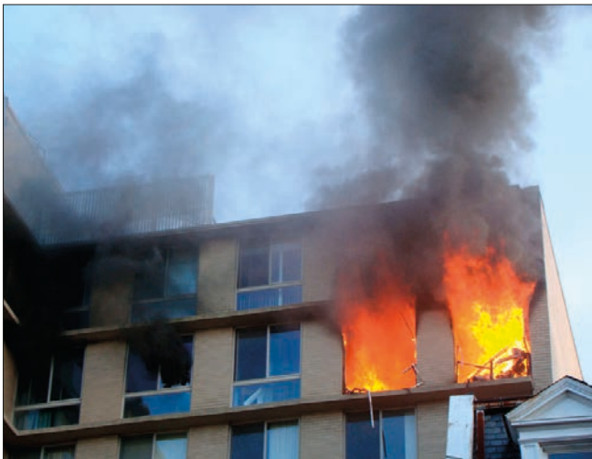
Imagen 17. Incendio en su etapa de pleno desarrollo. En este caso el recinto se encuentra ventilado y se produce una diferenciación clara de los estratos de gases de incendio y aire fresco como puede verse en las ventanas a nivel de incendio a su izquierda
