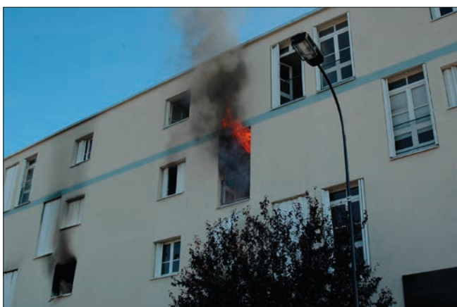
Imagen 23. Incendio en estado ILC
