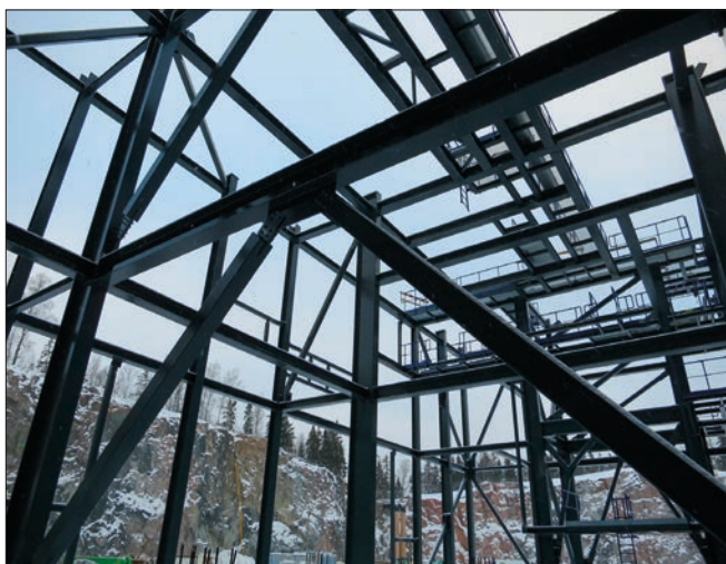
Imagen 24. Estructura de acero
