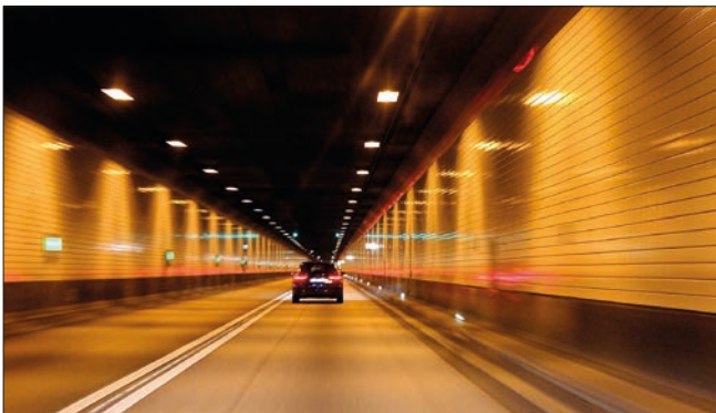
Imagen 22. Túnel de una autopista
