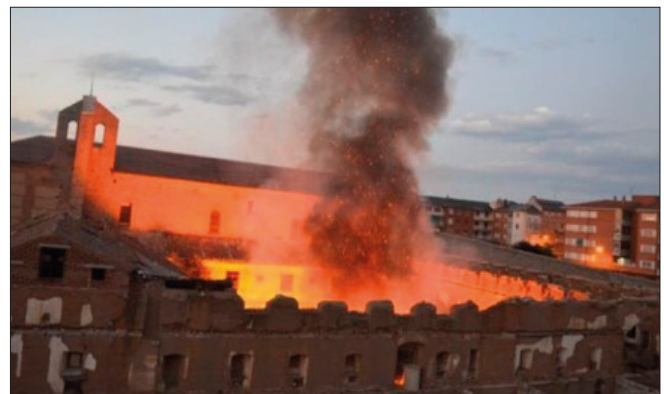
Imagen 166: Incendio en edificio antiguo
