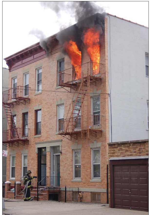
Imagen 47. Incendio en el que se puede identificar claramente el flujo de gases. La puerta del edificio funciona como entrada de aire y los ventanales abiertos como salida
